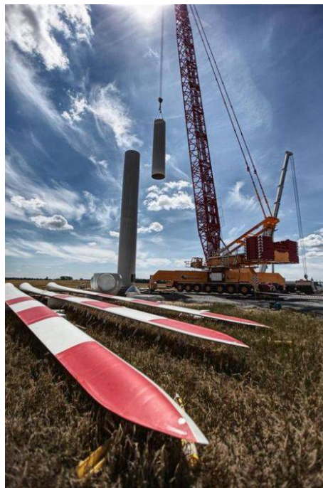
Rys. 100. Montaż wieży w „Zespole Elektrowni Wiatrowych Czyżewo” źródło: domrel.pl
