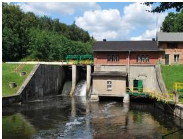
Rys. 97. Elektrownia Wodna „Kamienna” źródło: lubtur.pl
