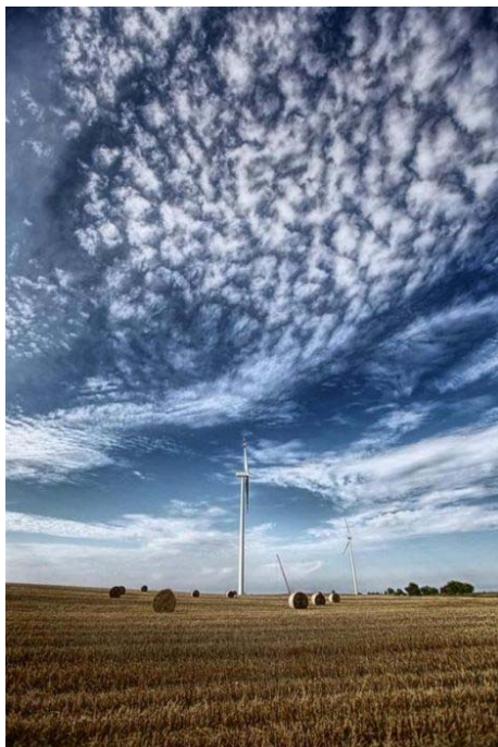
Rys. 99. „Zespół Elektrowni Wiatrowych Czyżewo” w trakcie budowy źródło: domrel.pl
