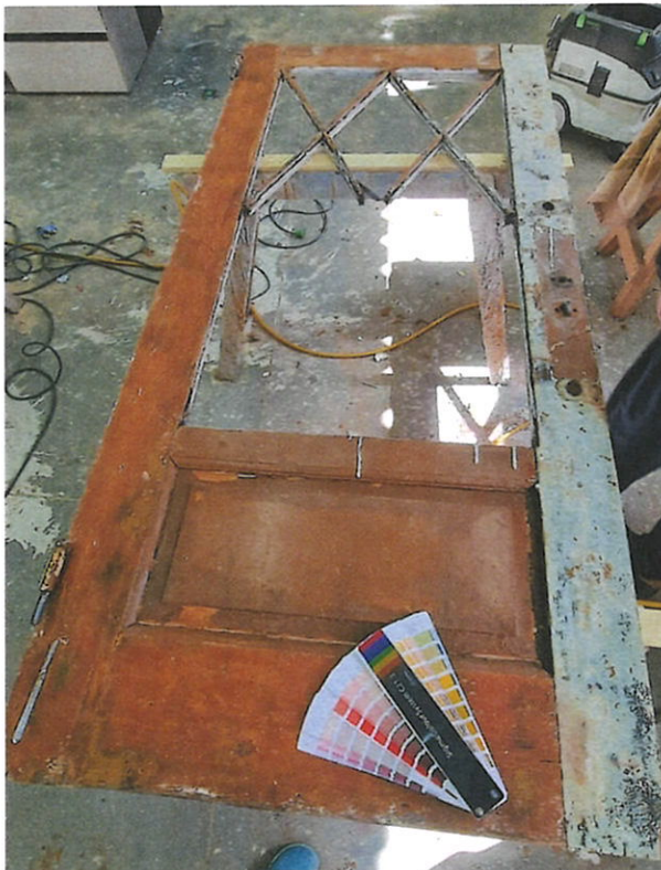
Drzwi zabytkowe 2- strona wewnętrzna - stan w czasie usuwania przemalowań, element ramy wtórny do wymiany; szprosy do uzupełnienia
