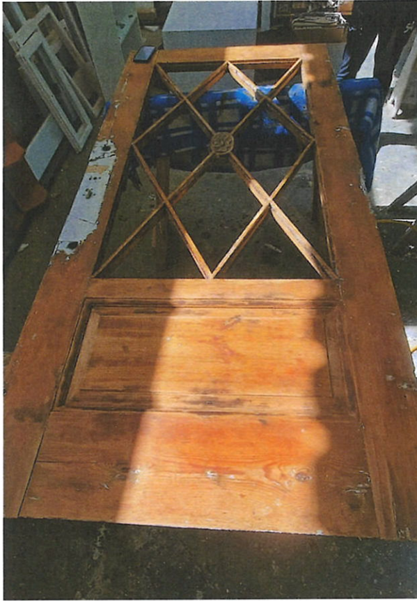
Drzwi zabytkowe 1- strona zewnętrzna - stan po usunięciu przemalowań, zachowane wszystkie elementy
