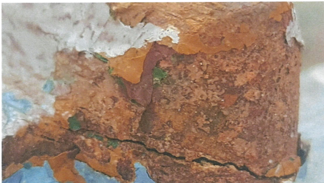
Zdjęcia elementu dekoracji drzwi z widocznymi zielonymi śladami pierwotnego opracowania barwanego
