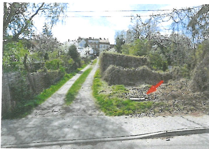
Szambo przykryte betonową płytą – kwiecień 2024 r. źródło Google Maps
