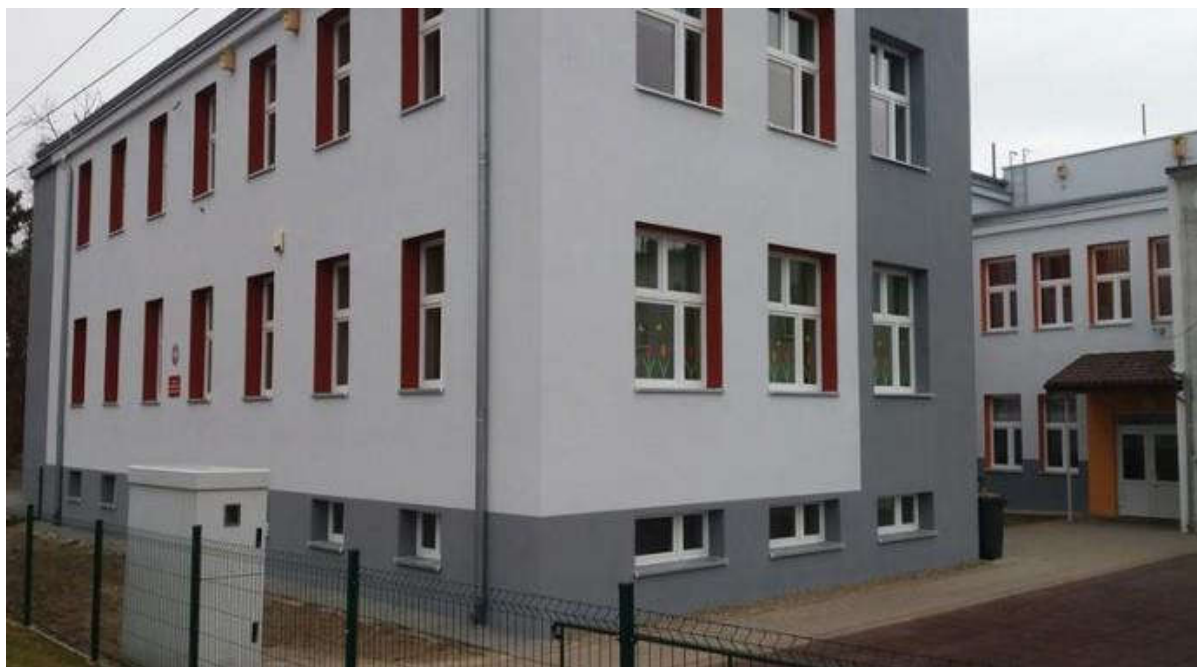
Rys. 38. Budynek Szkoły Podstawowej w Niegosławiu po remoncie źródło: drezdenecka.pl
